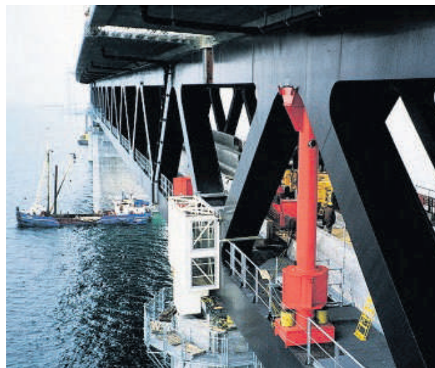
NHI leverede ENERPAC løfteudstyr, da Øresundsbroen blev bygget. Foto: ENERPAC
